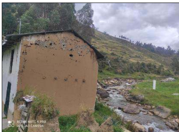
Figura 01. Se muestra una vivienda ubicada cerca a la ribera de la quebrada, sin presencia de obras de protección. Por su ubicación, presenta alta vulnerabilidad ante un posible desbordamiento, lo que podría ocasionar daños significativos..
