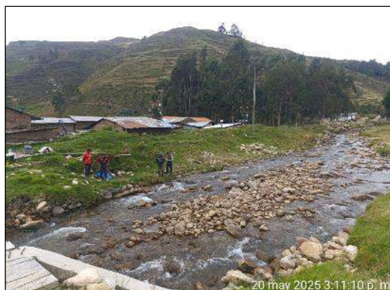
Figura 02. Se observa en el cauce de la quebrada acumulación de material fluvial (bloques, gravas y arenas), lo cual reduce su capacidad hidráulica y puede aumentar el riesgo de desbordamiento ante eventos de avenida.
